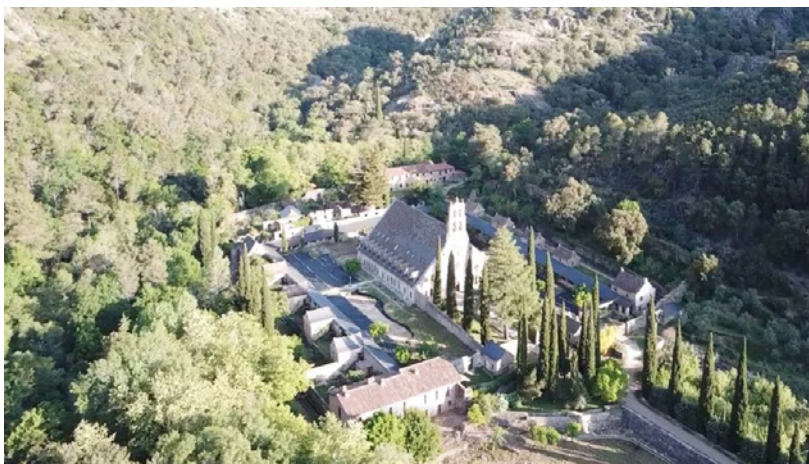
Figura 7. Convento carmelita de San José en Las Batuecas. Desamortizado y abandonado en 1836, su estado era ruinoso cuando lo visito y fotografió J. Bte. Bide en 1891 (arriba). Abajo, estado actual del convento tras las labores de reconstrucción y reordenación de todo el conjunto llevado a cabo en los últimos años
