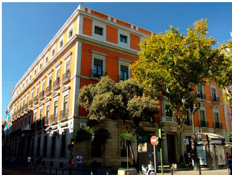
Figura 13b. Edificio construido para sede de los Cinco Gremios Mayores y posteriormente del Banco de Isabel II y del Banco de España (estado actual).
