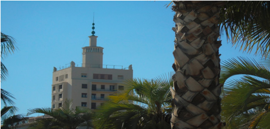
Figura 14. Fotografía Edificio de la Equitativa en la actualidad, visto desde el Muelle II del Puerto de Málaga.
