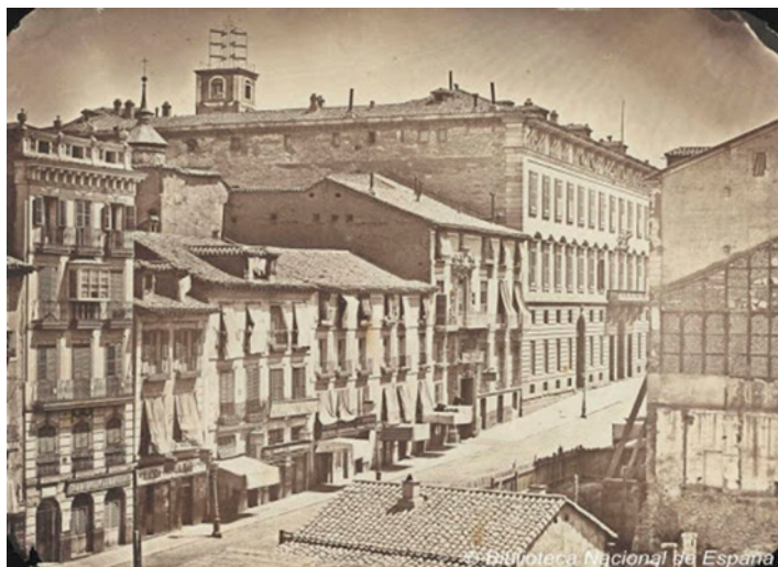
Figura 14a. Vista de la calle de Alcalá con la torre del telégrafo óptico situada sobre la Casa de la Aduana, arranque inicial de la línea a Valencia y Barcelona (ca.1856)
