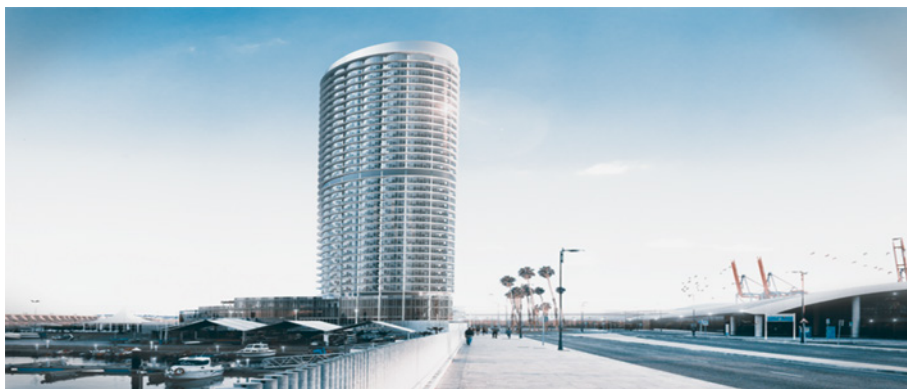
Figura 8. Proyecto Hotel del Puerto.
