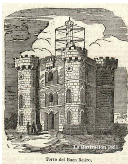
Figura 14b. Castillo del telégrafo óptico en El Retiro, sustituto de la Casa de la Aduana como central de la línea a Valencia y Barcelona. Desde 1850 también dio servicio a la de Andalucía.
