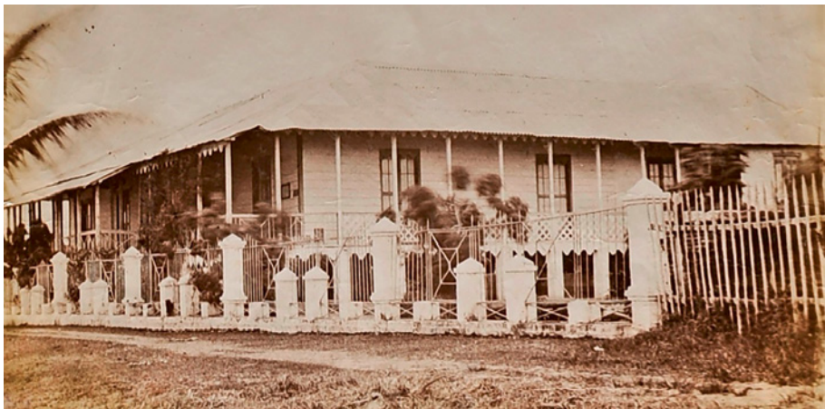
Imagen 2. Vista de la casa-gobierno de Santa Isabel después de las obras de reforma emprendidas por José Montes de Oca en 1885. Fuente: APCCS.
