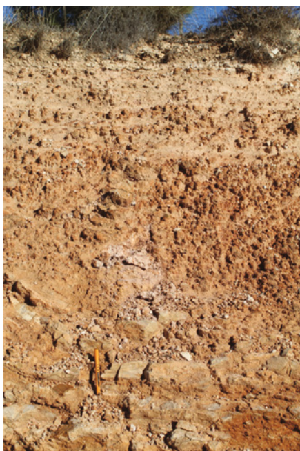
Muestra de la superficie culminante en corte, fuertemente calcificada, incluso con costras multiacintadas (bolígrafo), y de su topografía, en la que destaca el recubrimiento de cantos habitualmente orlados por carbonatos. (Foto propia)
