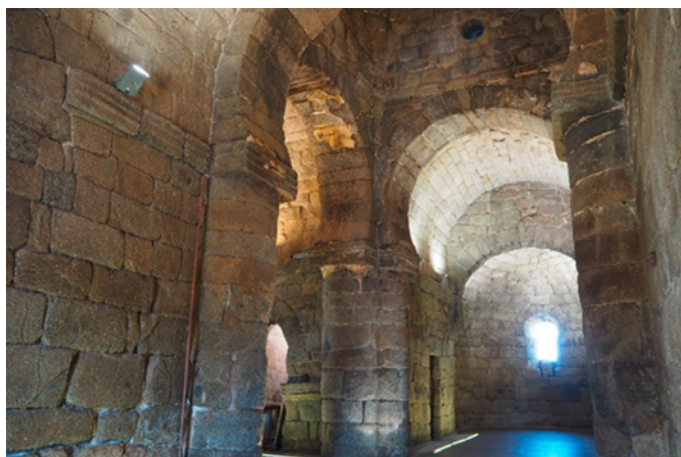
Aparejo de soga y tizón visigodo y arcos mozárabes en el interior de Santa María de Melque. Foto: A. Zárate.
