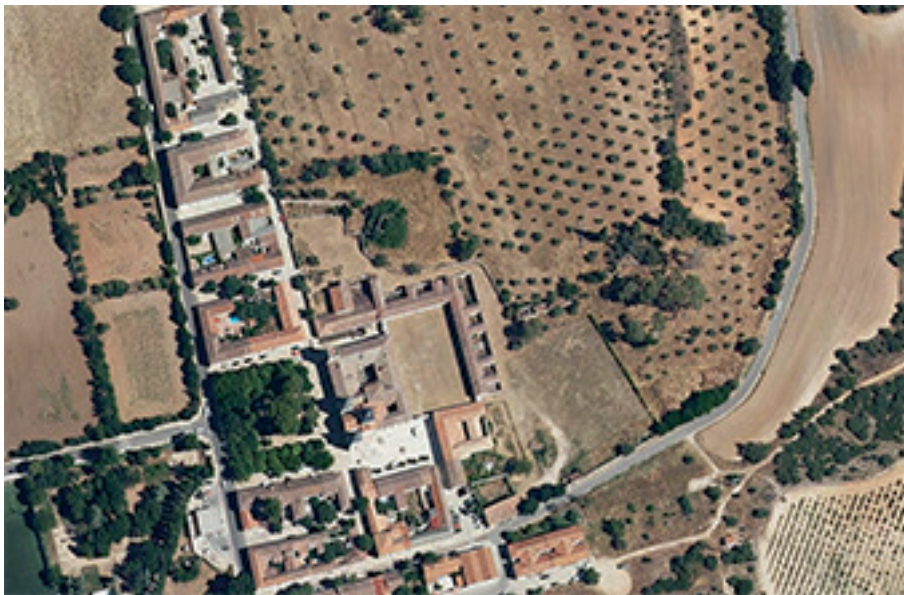
Imagen 2. Ortofoto actual del casco histórico de Nuevo Baztán y su entorno. Se pueden apreciar los edificios proyectados, así como su trazado en cuadrícula. Fuente: Instituto Geográfico Nacional, PNOA. Escala 1:2.132.
