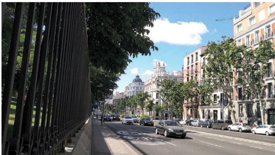
Figura 5. Fachada de la calle Alfonso XII frente al Retiro.
