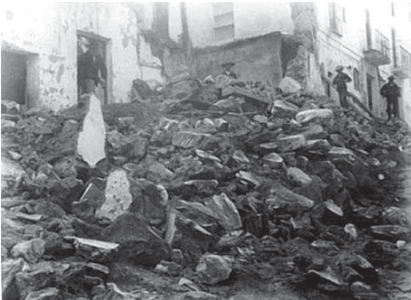
Foto 4. Alhama. Materiales de construcción. Fuente www.Alhama.com
