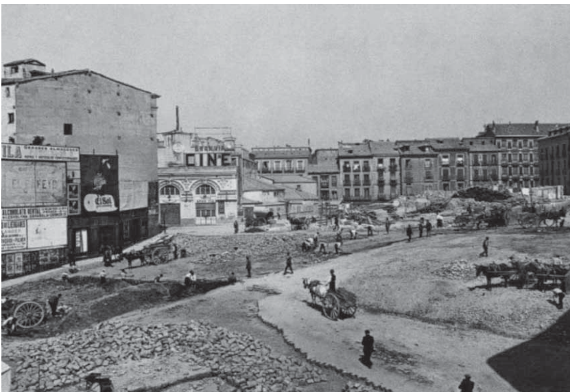
Figura 3. El Teatro-Cine Gran Vía durante la remodelación de la Plaza Callao, ha. 1920-1930.
