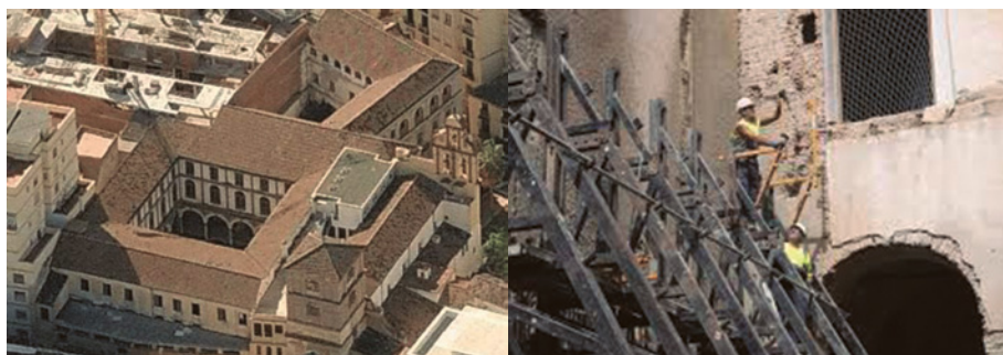
Figuras 17 y 18. Edificio del antiguo Convento de San Agustín y obras de rehabilitación y transformación en Biblioteca Pública del Estado.
