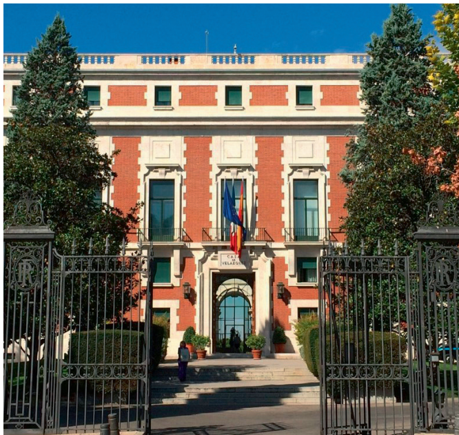
Figura 6b. Imagen del segundo edificio, resultante de la reconstrucción concluida en 1959, en el que han desaparecido las dos torres con sus chapiteles y la portada del palacio de Oñate.
