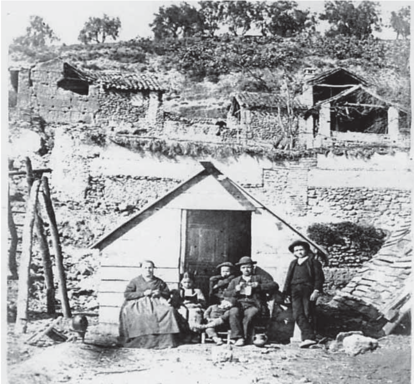
Foto 6. Abuñaélas. Familia ante su barraca, viviendas destruidas y materiales constructivos.
