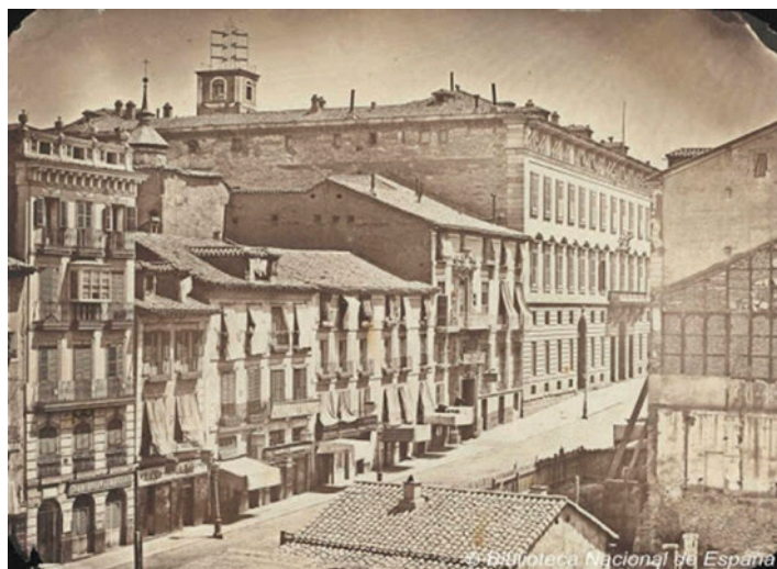
Figura 14a. Vista de la calle de Alcalá con la torre del telégrafo óptico situada sobre la Casa de la Aduana, arranque inicial de la línea a Valencia y Barcelona (ca.1856)
