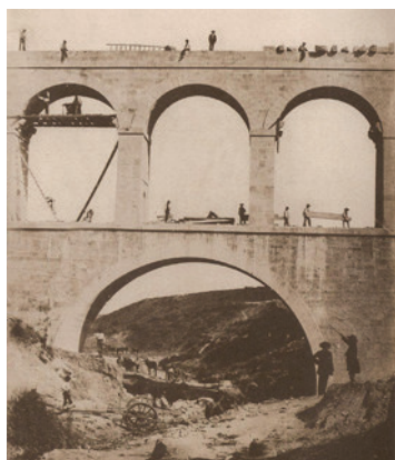
Figura 17a. Canal Isabel II. Acueducto de la Sîma, 1855. Fuente: Charles Clifford. Archivo fotográfico Pinterest.
