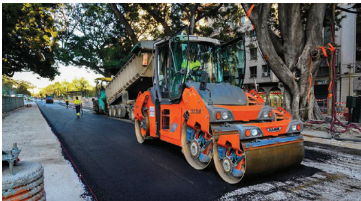
Figura 11. Fotografía de trabajos de asfaltado de Alameda Principal en Málaga, trabajos del Metro de la ciudad.
