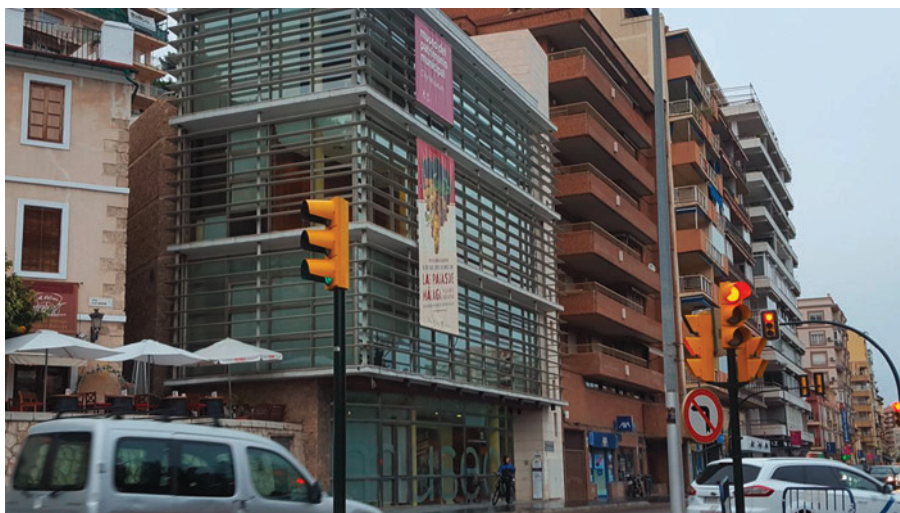
Figura 5. Fotografía actual de la zona baja de la Coracha y entrada a Paseo de Sancha tras su demolición. Puede apreciarse la esquina este de uno de los antiguos edificios en la zona izquierda de la fotografía y la construcción del Museo del Patrimonio del Ayuntamiento de Málaga.
