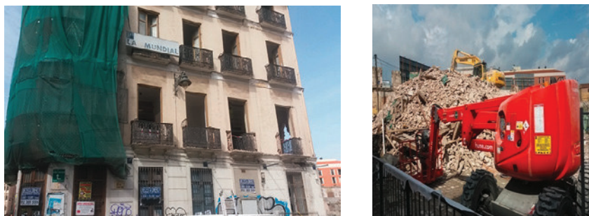
Figuras 16 y 17. Fotografía de inicio de obras del edificio del Hostal La Mundial con retirada de rejas y algunos materiales del edificio antes de proceder a su demolición. El lunes 1 de abril 2019 presentaba esta imagen el solar del edificio de La Mundial, en plena demolición y retirada de materiales.
