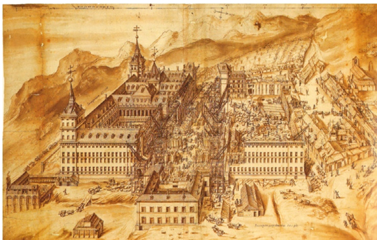
Figura 17. El Escorial en obras (1576).
