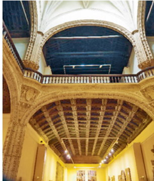
Figura 49. Cruce de las naves en el Hospital de Santa Cruz de Toledo. Foto: © A. Zárate.
