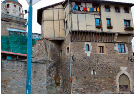
Figura 41. Vivienda de origen medieval sobre una antigua torre de defensa de la muralla de Vitoria. Foto: © A. Zárate.
